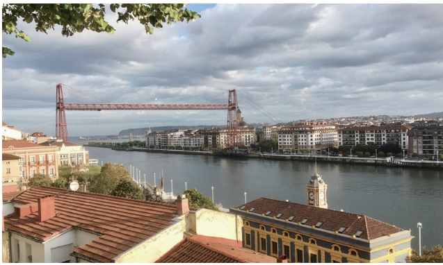
重工業で栄えたビルバオを象徴する世界遺産の運搬橋「ビスカヤ橋」(2019年9月、筆者撮影)
